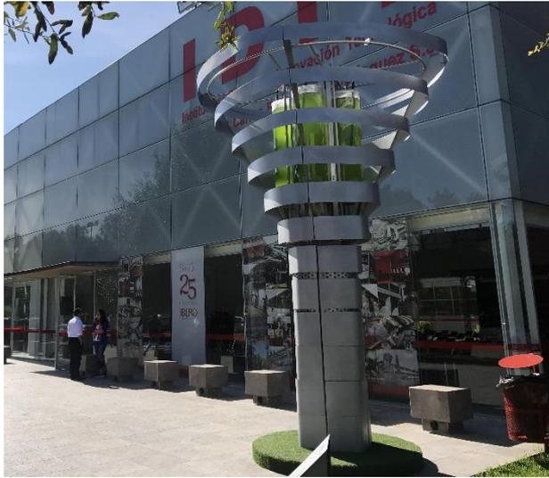
► Sistema de aire con filtración de microalgas
