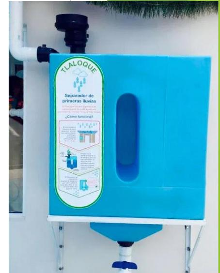
Sistema de con captación de agua de lluvias para zonas poco acceso a agua potable.
